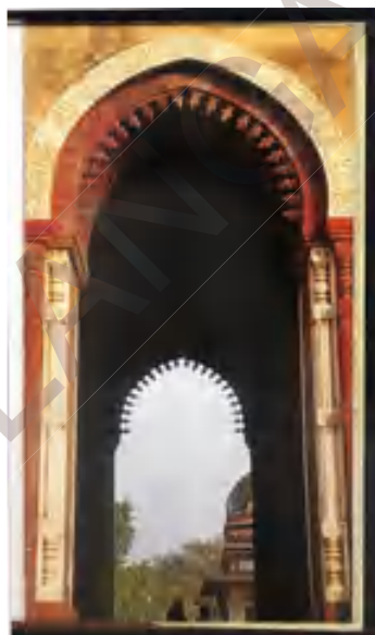
చిత్రం-22.5ఎ ట్రూ ఆర్చ్. ఆర్చ్ మధ్యభాగంలోని కీలకమైన రాయి ఆ కట్టడపు మొత్తం బరువును ఆర్చ్ ఆధార పీఠానికి మార్చేటట్లు అమర్చిఉంది.
