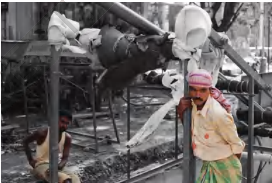
చిత్రం 19.5 రోడ్డు మరమ్మత్తులు, నిర్మాణాలు
